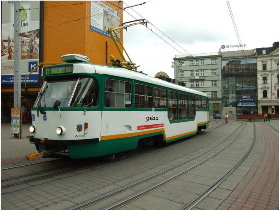
Ryc. 4. Dwusystemowy odcinek linii tramwajowej w Libercu
