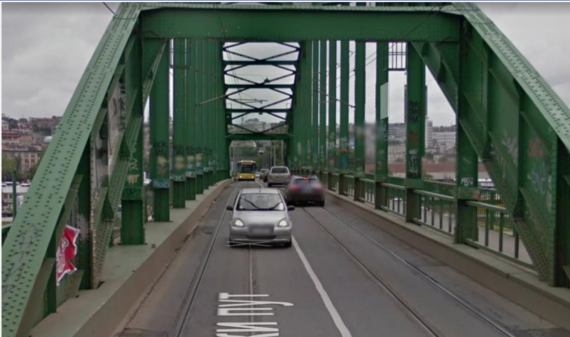
Ryc. 5. Odcinek mostowej linii tramwajowej umieszczonej w jezdni, Stary Most na Sawie w Belgradzie
